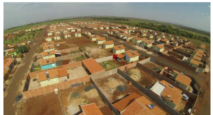
Fig. 3. Vista Aérea de bairro residencial atendido pelo PMCMV.
