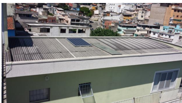
Fig. 4. Instalação da placa fixa na residência com ângulo de aproximadamente 23. Graus
