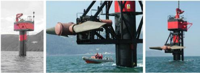
Fig. 4. Turbinas SeaGen – 11m diâmetro – Canal de Bistol – Inglaterra – 300kW
