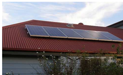
Fig. 8. Instalação das células fotovoltaicas
