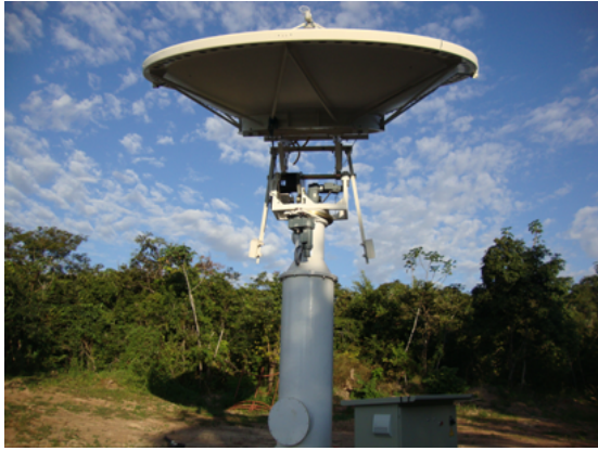
Fig. 4. Equipamentos externos: Antena com posicionador elétrico e cabine abrigada com conversores de frequência AC.
