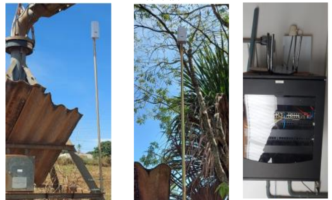
a) Antena do rádio no pivô b) Antena na casa de bombas c) Modem usado na comunicação
