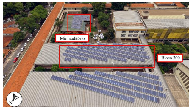
Figura 1: Vista aérea dos SFV's do Campus Goiânia do IFG.
