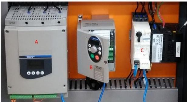
A esteira possui um motor que pode ser ligado por somente um dos equipamentos mostrados na figura 2. Desta forma, inicialmente, o usuário deve escolher qual será o tipo de partida do sistema. Também é possível fazer o controle de carga da esteira através de uma célula de carga.
