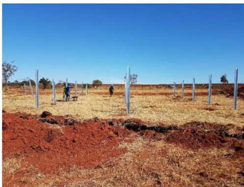
Figura 7: Assentamento da base das estruturas dos módulos fotovoltaicos
