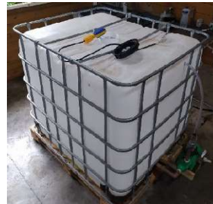
Figura 9: Reservatório com chave de nível
