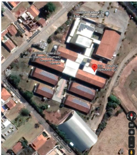
Figura 6 – Vista aérea da Instalação dos módulos FVs do IFG Campus Inhumas-GO
