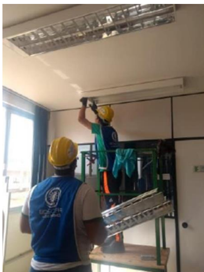
Figura 4 – Execução do serviço de retrofit de iluminação no IFG.
