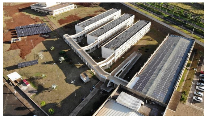
Figura 5 – Vista área do IFG Campus Itumbiara-GO
