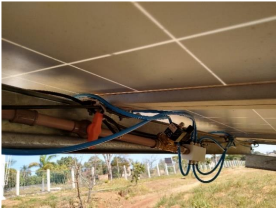
Figura 7: Detalhes da tubulação com mangueiras de poliuretano.
