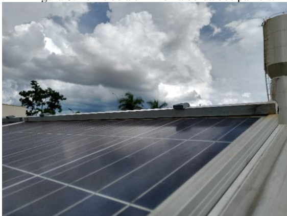
Figura 8: Perfis de alumínio na borda dos painéis.
