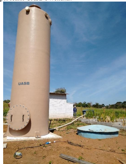
Figura 5: Sistema de tratamento de esgoto do Campus Aparecida, composto por reator UASB e Wetland .
