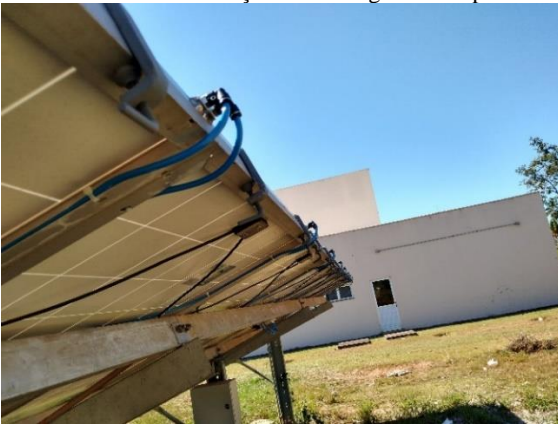
Figura 7: Detalhes da tubulação com mangueiras de poliuretano.
