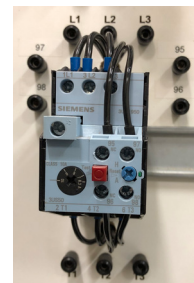
Figura 5: Relé de sobrecarga.
